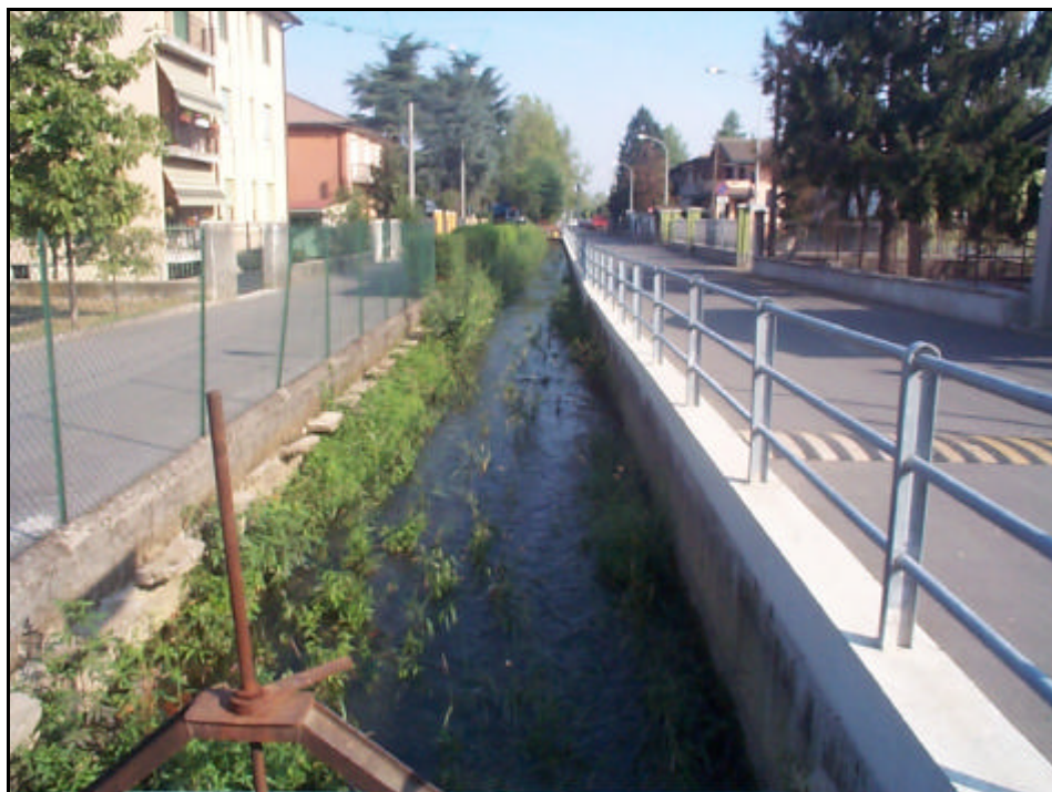
Roggia Brembilla (n. 2) in prossimità del punto di possibile crisi idraulica
