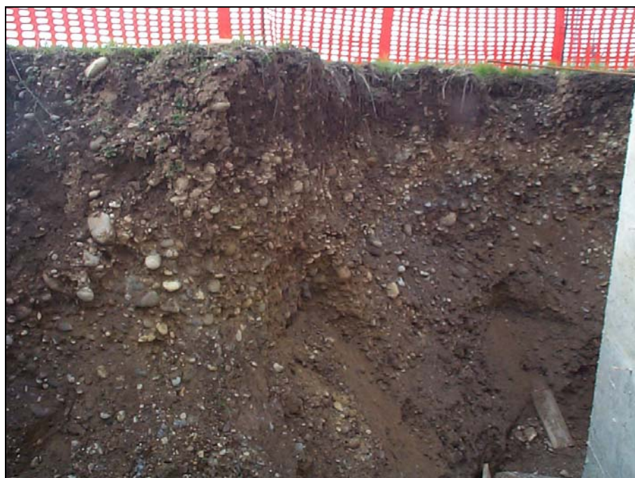
Foto n. 16 – Caratteristiche stratigrafiche del terreno costituente il sottosuolo
