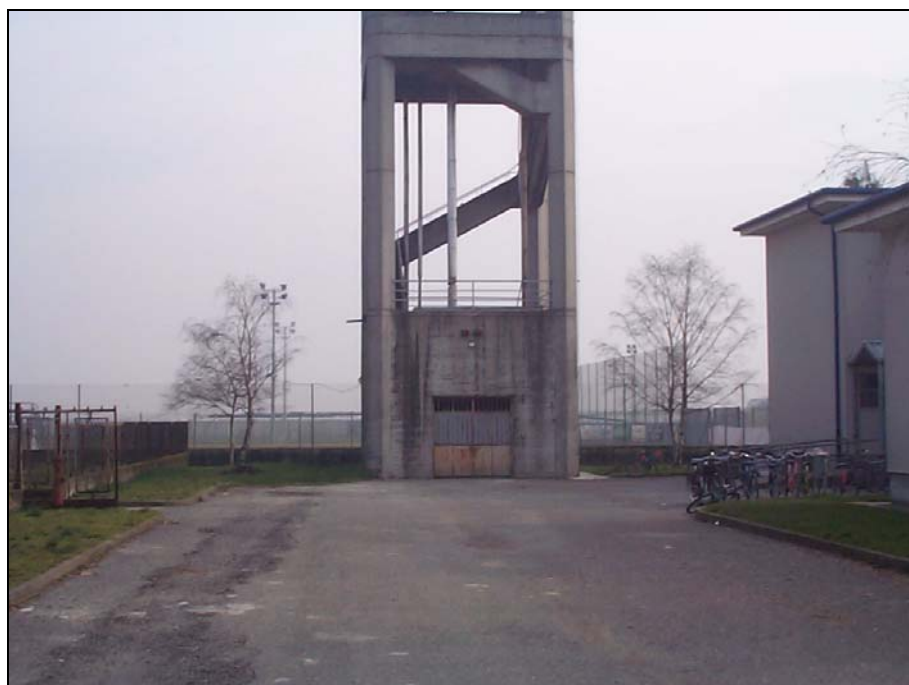
Foto n. 10 – Serbatoio idrico dell'acquedotto comunale
